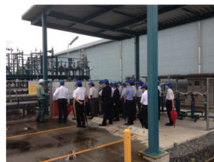
LNG サテライト設備
